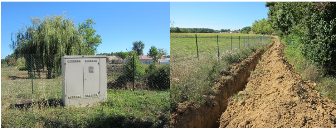
Poste de livraison du gaz, établissement GEORGELIN et tranchées visant à modifier le tracé du réseau de distribution de gaz
